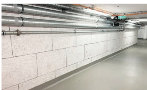
Tiefgaragen- und Kellerwände
