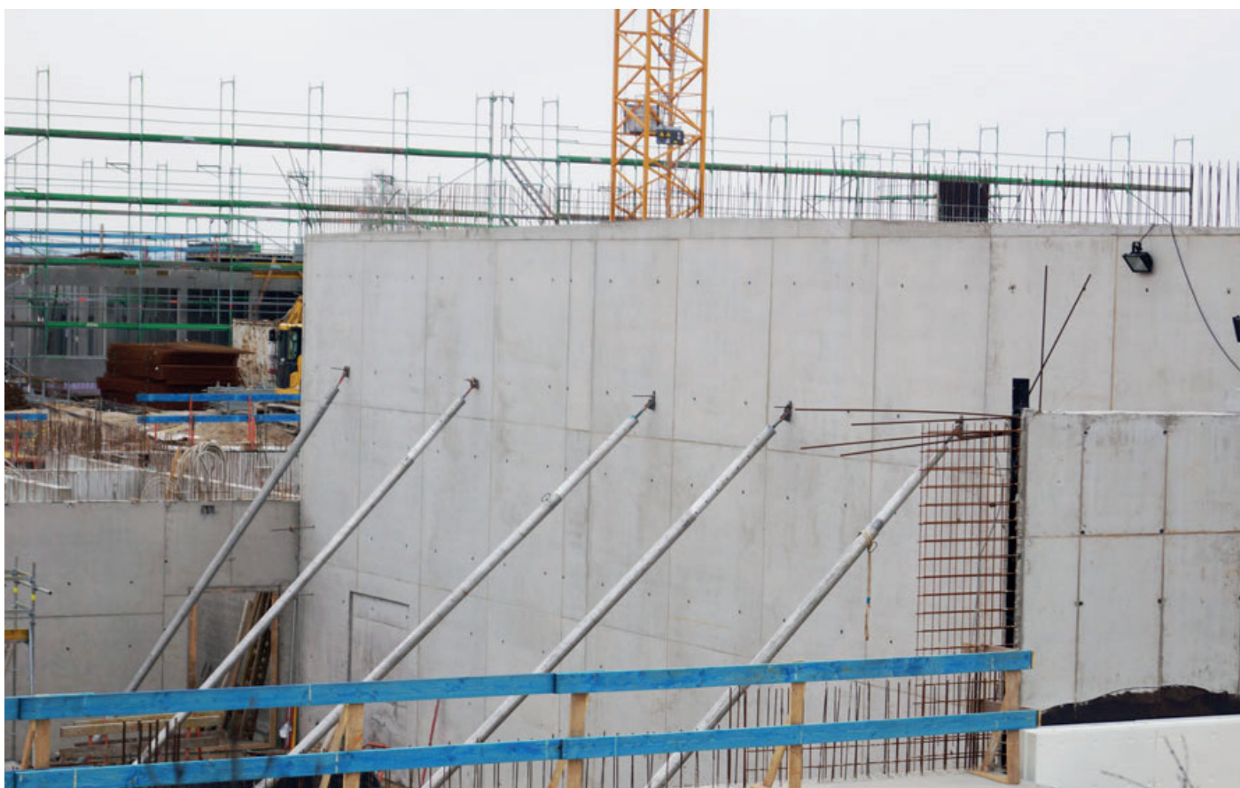
Befestigung von Absturzsicherungen, Gerüsten bzw. Schalungstützen
