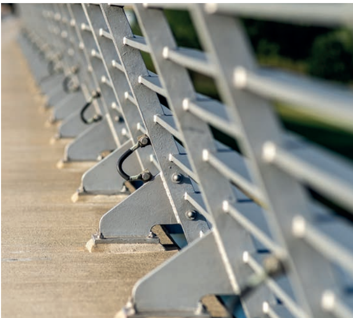
Befestigung von Geländern und Handläufen
