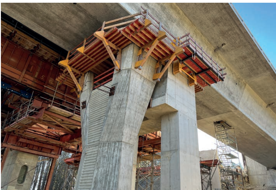
Befestigung von Gerüsten und Schalungen im Sanierungsbereich
