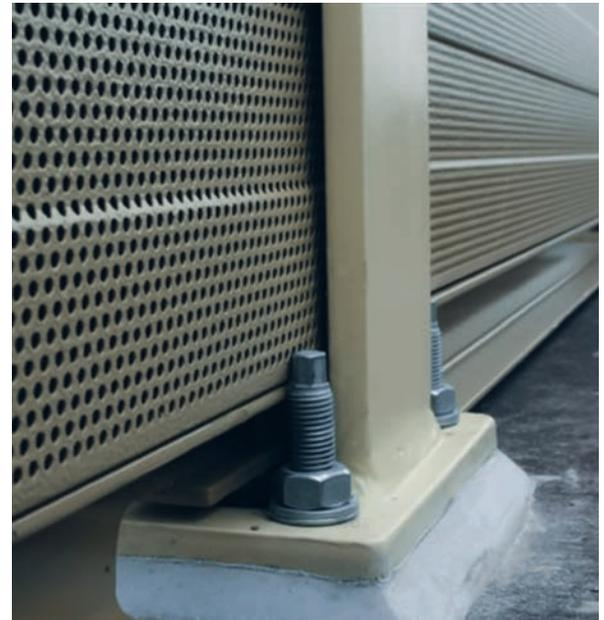
Befestigung von Lärmschutzwänden auf den Bauwerken der DB
