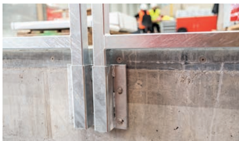
Befestigung von Geländern
