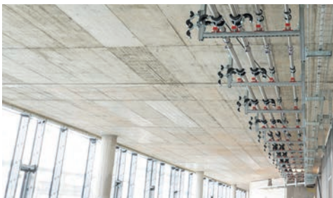
Befestigung von Rohrleitungen
