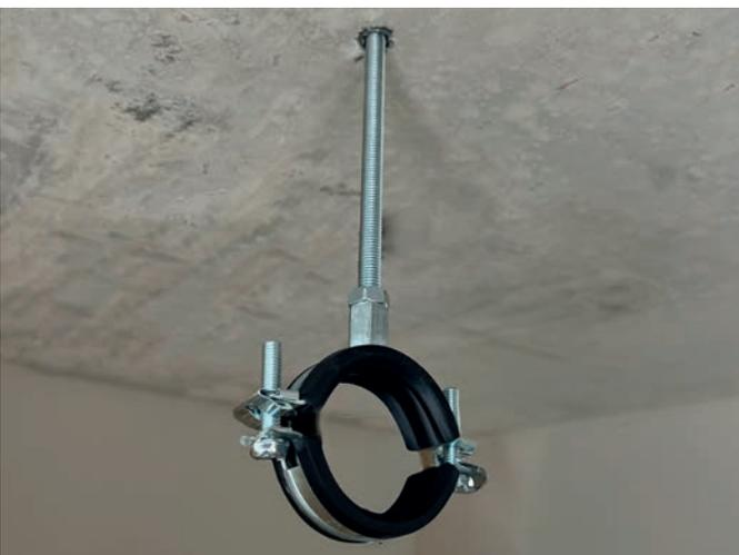
Detail: TSM Multiground mit Gewindestange und Rohrschelle
