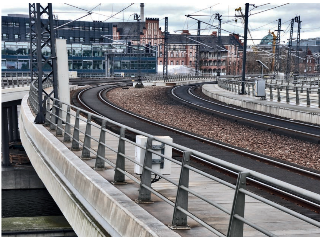
Befestigung von Geländern und Berührungsschutz auf den Bauwerken der DB
