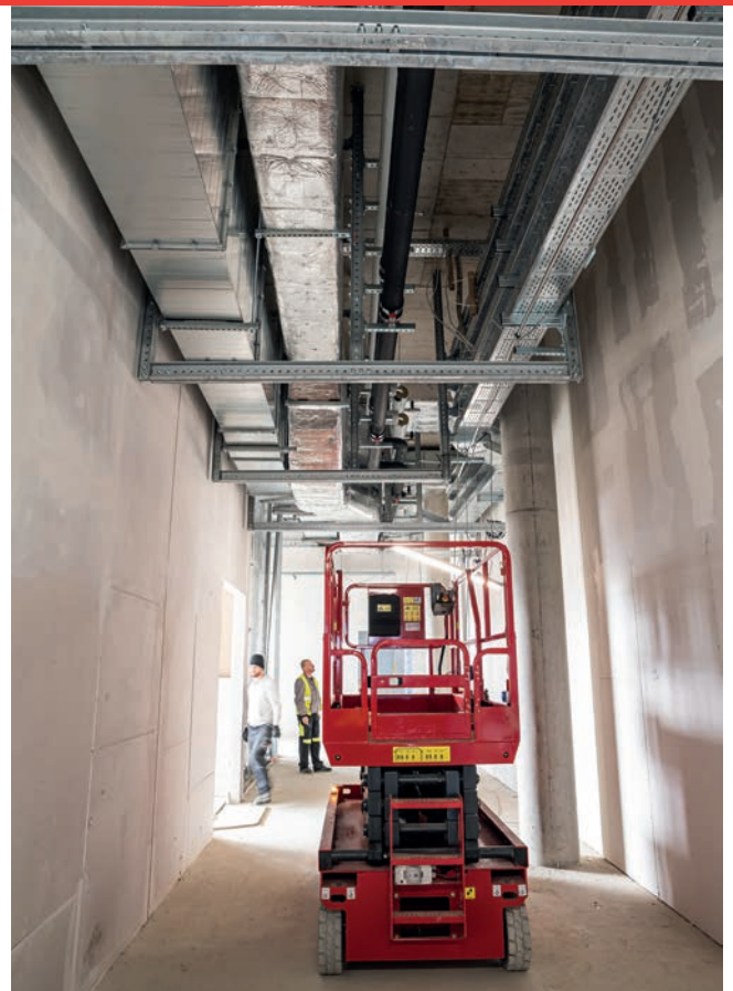
Befestigung von Lüftungskanälen
