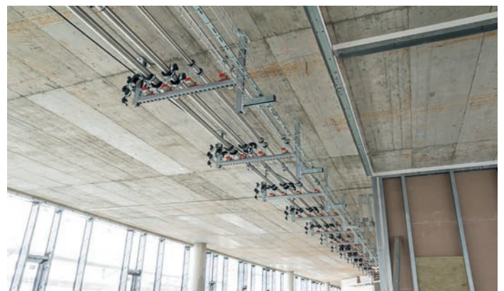
Befestigung von Rohrleitungen
