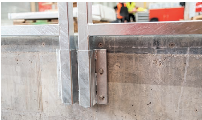
Befestigung von Geländern
