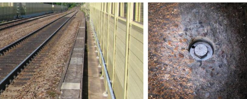
**Abb. 1: Beispiel einer Brückenkappe mit nachträglich aufgestellter LSW und nachträglich eingebauter Kappenverankerung** (Quelle: TOGE)
