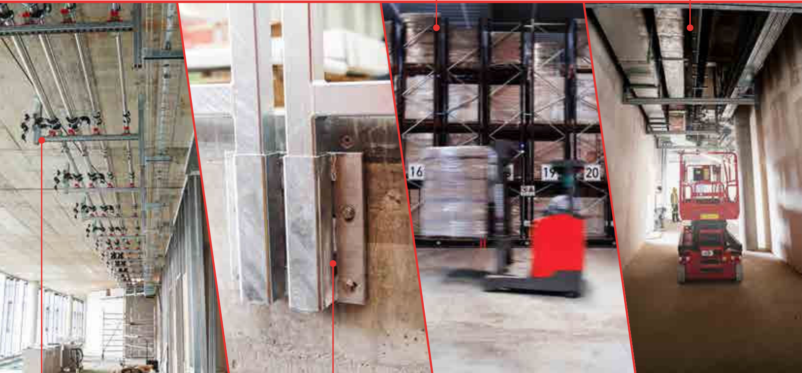
Befestigung von Rohrleitungen
