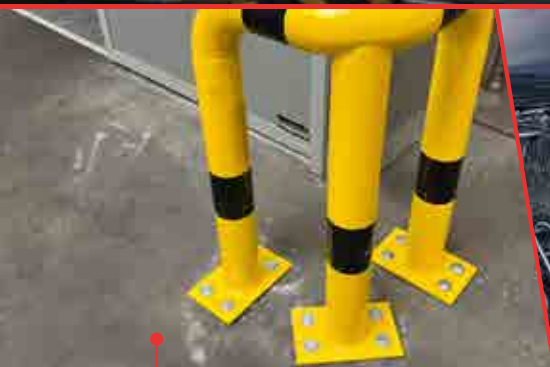
Befestigung von Rammschutz-Systemen
