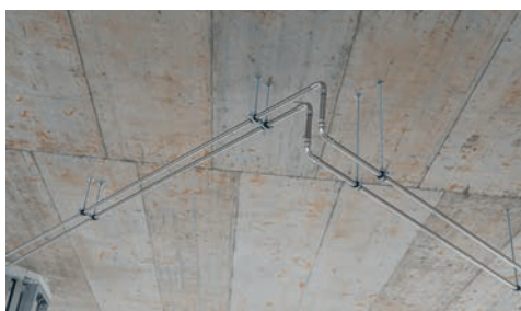
Befestigung von Rohrleitungen
