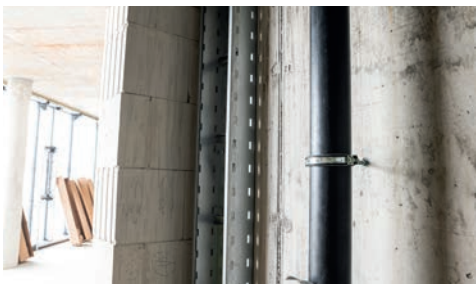
Befestigung von Kabelkanälen
