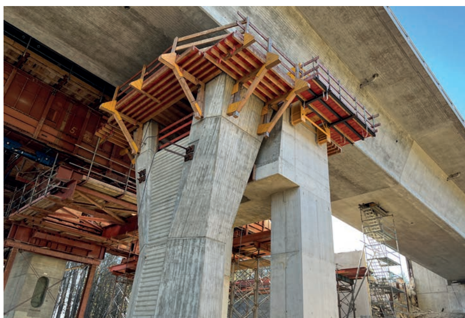
Befestigung von Gerüsten und Schalungen im Sanierungsbereich
